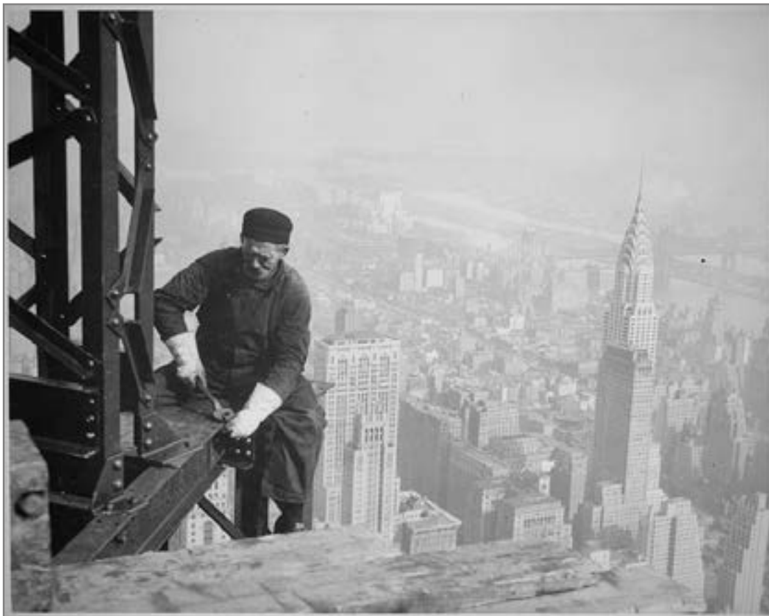
Lavoratore sulla struttura dell'Empire State Building, New York, 1930-1931
