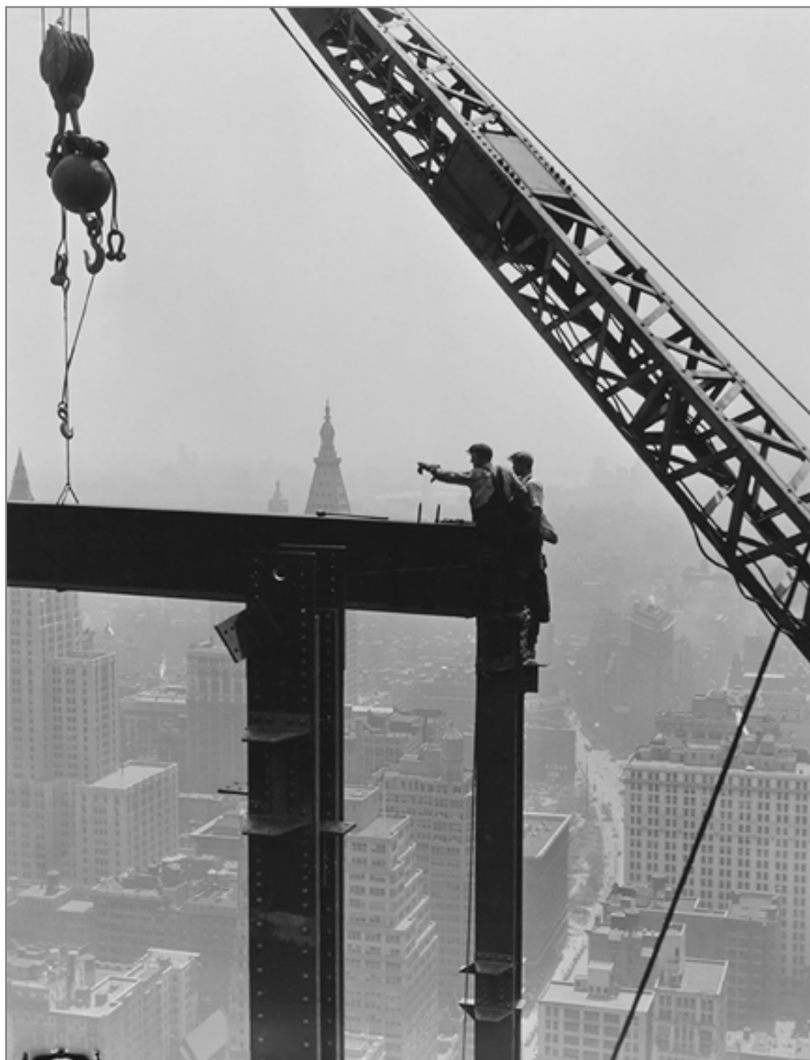
Gru a torre e operai su una trave 1930-1931
