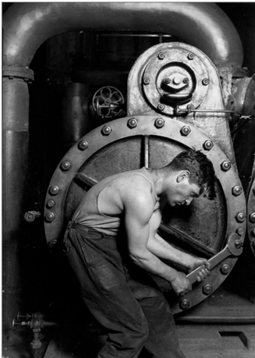
Meccanico di centrale elettrica al lavoro su una pompa a vapore, 1920
